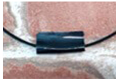
光ケーブルの固定
