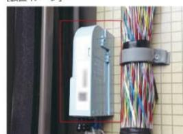
建物内光配線は細径、低摩擦の光ファイバークーブルにて配線
